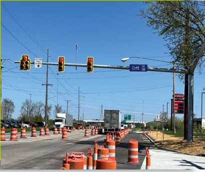
US 62/SR 21 (Erie Ave.) & Ortt St. SW New Sheetz Access Road, Perry Township
